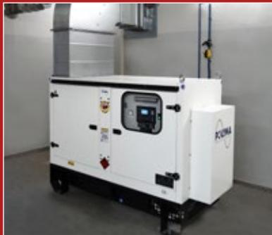
Innenaufstellung eines Kufenaggregates mit Schallschutzhaube.
