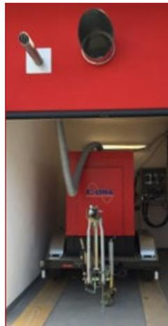
Mobiles Aggregat in Garage für Notstromautomatik angeschlossen, inkl. Abgasherausführung und Abluftventilator
