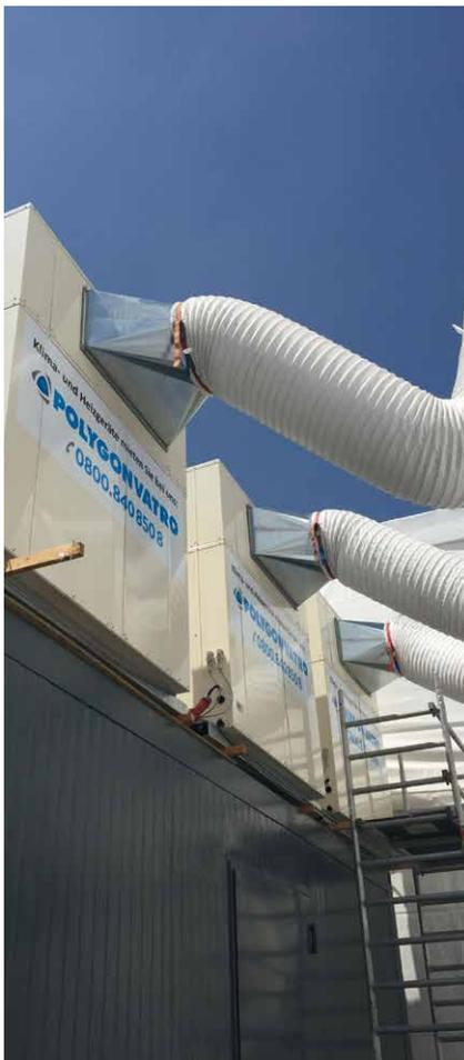
Temperaturschwankungen wirken sich schnell negativ auf die beim Bau benötigten Maschinen und die Arbeitsbedingungen aus. Die terminierten Arbeitsprozesse werden erheblich behindert, verzögert oder schlimmstenfalls sogar gestoppt. Das führt zu Vertragsstrafen, Reputationsverlust und geschäftlichen Einbußen.
