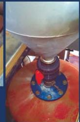
Anschließend wird der Saugschlauch an den Spezialstutzen im unteren Bereich des Silobehälters angeschlossen. Durch Vakuum wird jetzt das Löschpulver vollautomatisch und absolut staubfrei wieder zurück in den Pulvertank gefüllt.
