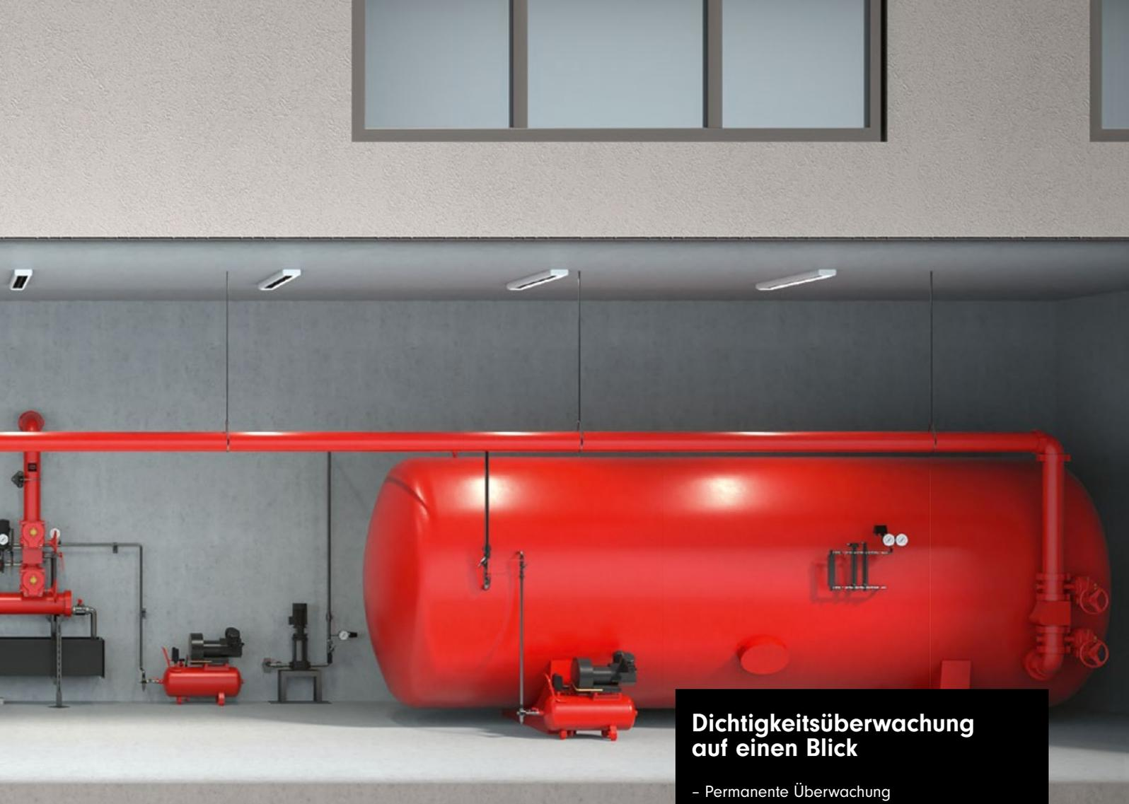
wird regelmäßig der Druckverlust in den Rohrnetzen ermittelt. Gibt es Anzeichen für zunehmende und unzulässig große Leckagen, hat der Instandhalter den Vorteil, dass er schon weiß, welche Station bzw. welches Rohrnetz betroffen ist und wo genau eine Leckageprüfung stattfinden sollte. In der Regel handelt es sich dabei um Kupplungen oder Verschraubungen, die relativ einfach auffindbar und abzudichten sind.
